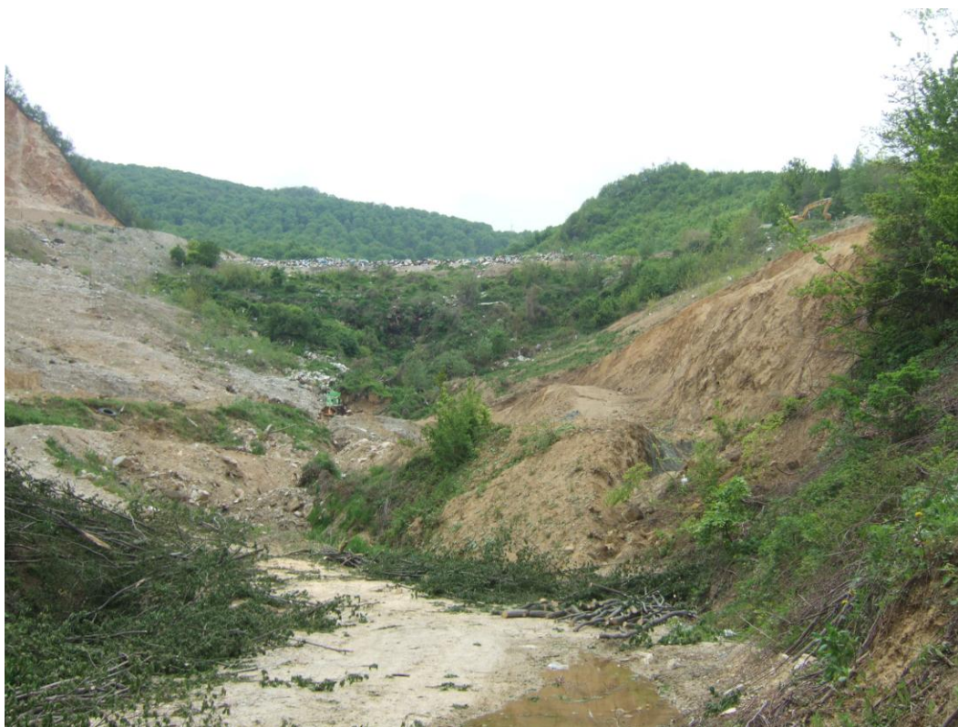
Slika 5 - pokos postojećeg odlagališta na kojem su uočene nestabilnosti
